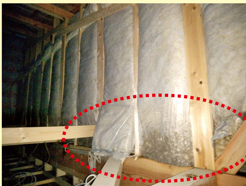
水(泥水)を吸った断熱材
