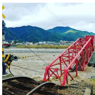
橋脚が落下した上田市別所線
