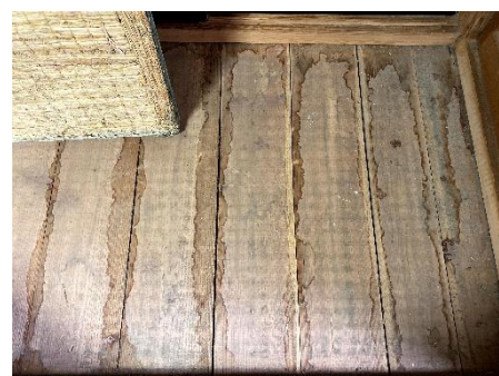
内部断熱材(グラスウール)を撤去せずに内装改修した結果カビ発生 7月
