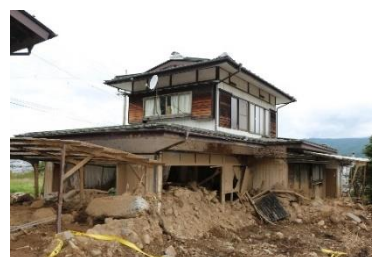
上：木曾川の氾濫（木曾町）
