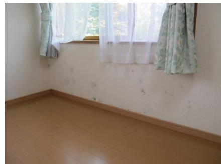
内部断熱材(グラスウール)を撤去せずに内装改修した結果カビ発生 7月
