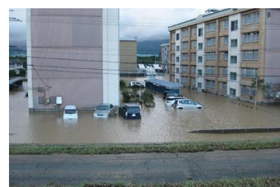
須坂市北相之島地区の浸水被害
