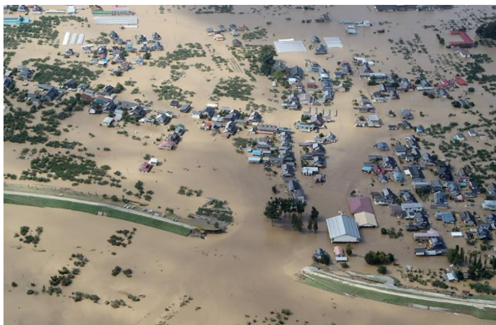
千曲川堤防決壊箇所 長野市穂保長沼支所近く (令和元年10月13日) 右下の大きな屋根が長沼体育館、その 上が長沼支所
